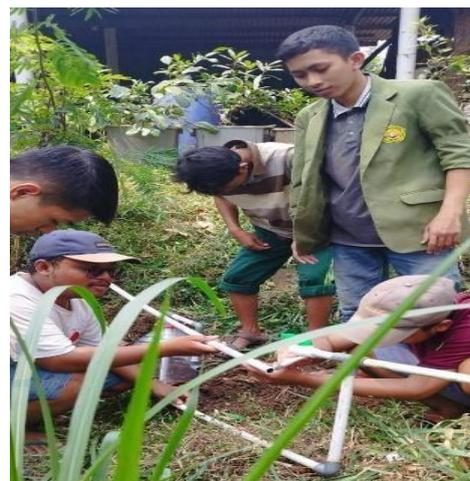
**Gambar 2.** Pemasangan pipa Water Trap dan Absorber Gas
